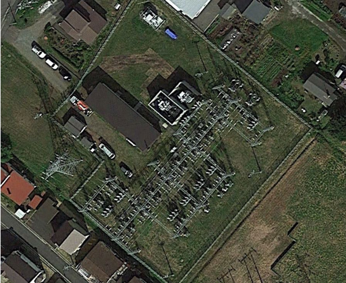
Figure 3-13. Hayakita 66 kV Switchyard (Latitude 41.7612 Longitude 141.8125)
