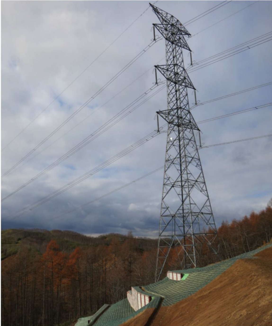
Figure 3-20. Repaired 275 kV Tower (Latitude 42.7804, Longitude 141.9745)
