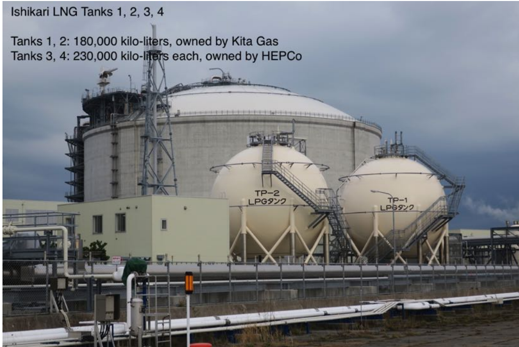
Figure 4-4. LNG Tank 1 at Ishikari Port
