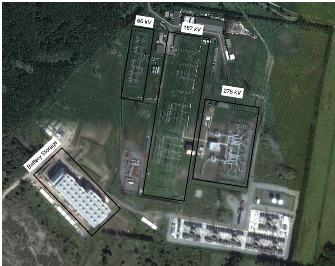
Figure 3-7. Minami-Hayakita 275 kV Substation (Latitude 42.7140 Longitude 141.7815)
